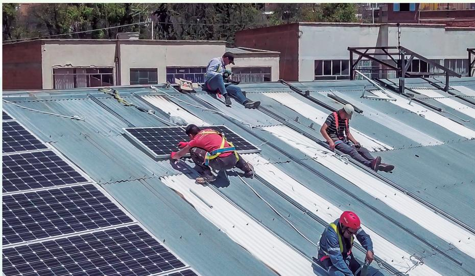
Fotografías: Instalación de paneles solares en el Hospital Arcoiris.
